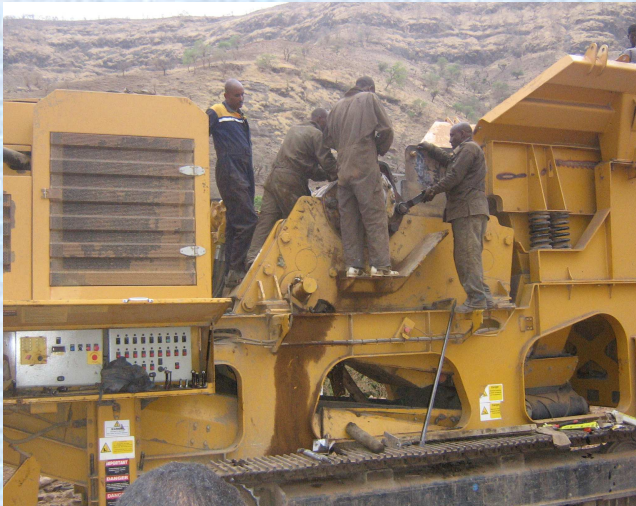
የገበኮን ቲም በጥገና ወቅት/GEBECON TEAM During Maintenance
