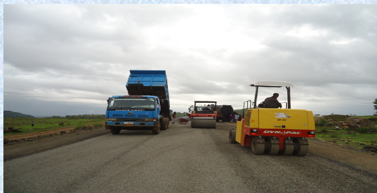
የአስፋልት ስራ የማይፀምራ-ዲማ ፕሮጀክት /Asphalt Surfacing Work, Maytsebry-Dima Road Project
