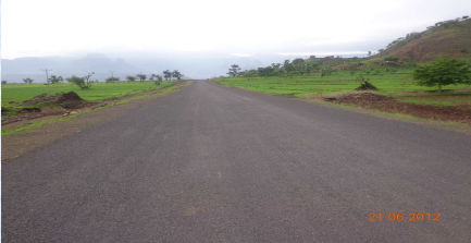
የተመረቀው የአስፋልት መንገድ ክፍል/ Completed Asphalt Section
